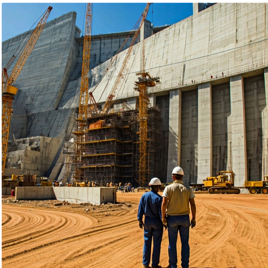
Construção da Usina Hidrelétrica de Itaipu, um dos maiores projetos de infraestrutura do regime militar, simbolizando a ambição desenvolvimentista da época.
